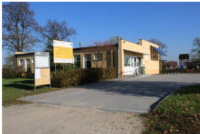
Zdjęcie 13. Świetlica wiejska w Zakrzewku
