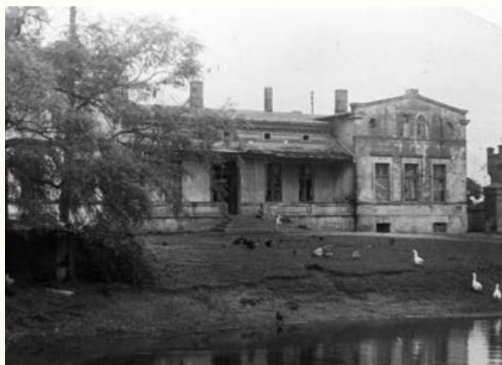
Widok na dwór od frontu po 1945 roku 684
