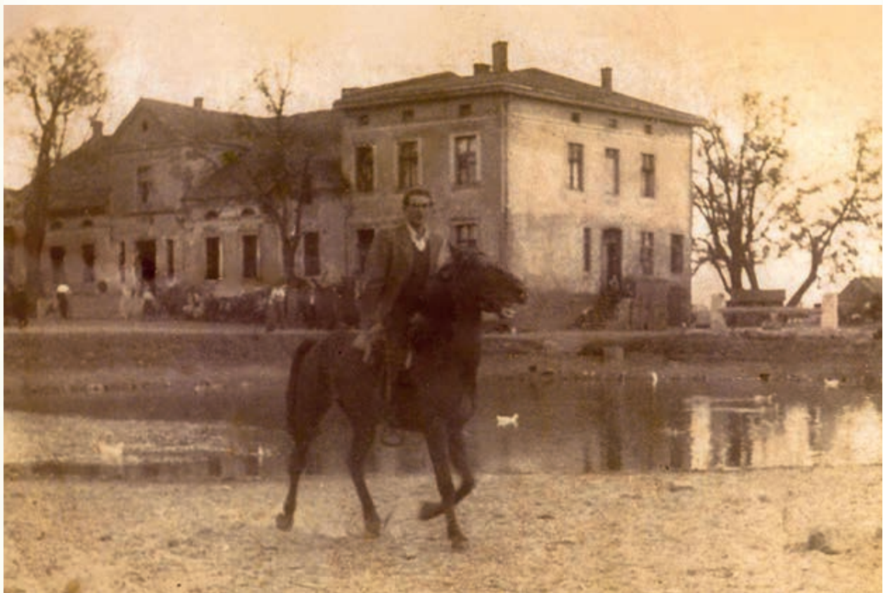
Nieistniejący dwór w Wytrębowicach. Zdjęcie robione najprawdopodobniej zaraz po wojnie 650
