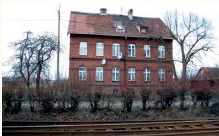
Budynek przy ulicy Dworcowej 9 w Turznie. Okno nad anteną TVN, należało kiedyś do mieszkanka, w którym mieszkała rodzina Matuszewiczów 601
