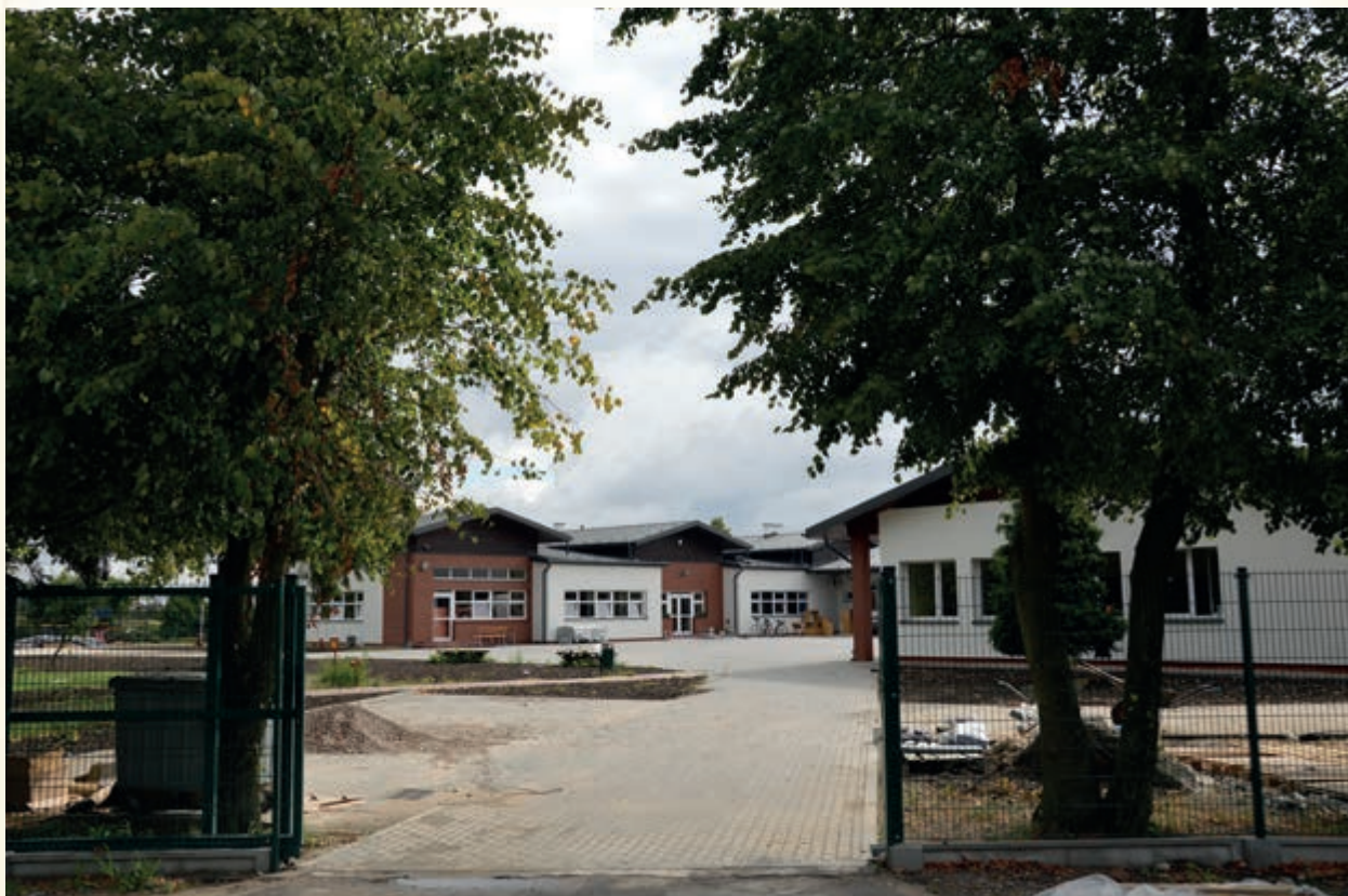
Remontowana szkoła w Świerczynkach (zdj. K. Pawłowska, 2014 r.)
