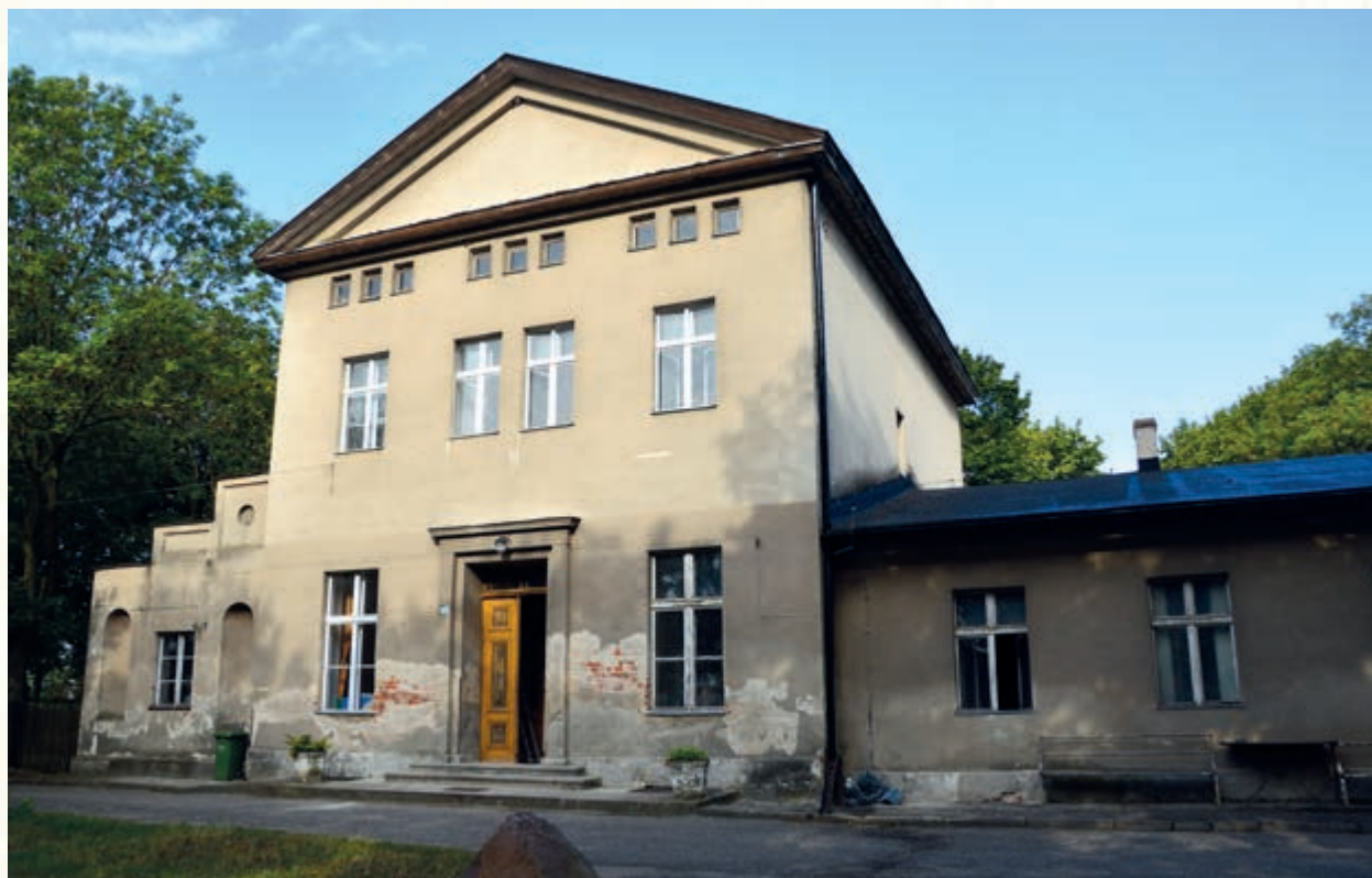
Dwór w Piwnicach od frontu (zdj. K. Pawłowska, 2014 r.)
