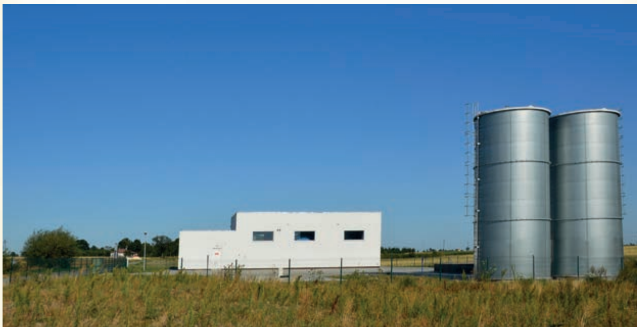
Stacja uzdatniania wody w Świerczynach (zdj. M. Pawłowski, 2014 r.)
