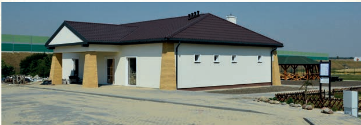
Budowana świetlica wiejska w Kamionkach Małych (zdj. M. Pawłowski, 2014 r.)
