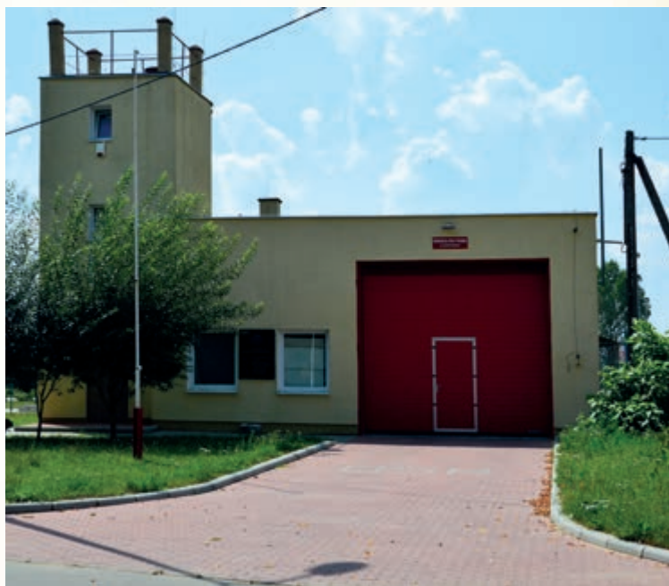
Obecny wygląd odnowionej i rozbudowanej remizy w Gostkowie (zdj. M. Pawłowski, 2014 r.)
