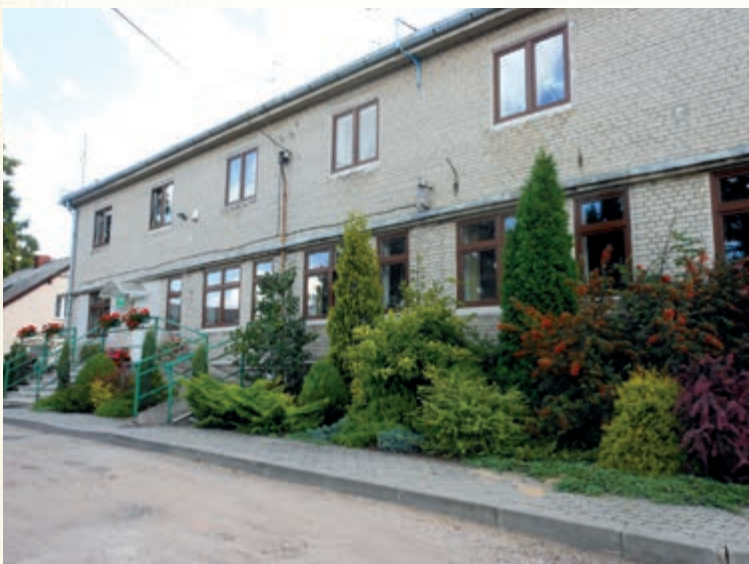
Współczesny budynek na miejscu dawnego dworu (zdj. K. Pawłowska, 2014 r.)
